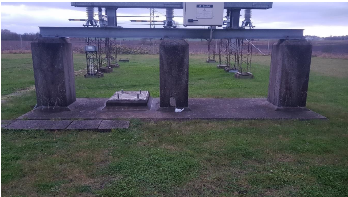
Figur 5: Foto af apparatfundament og mastefundamenter bagved.
